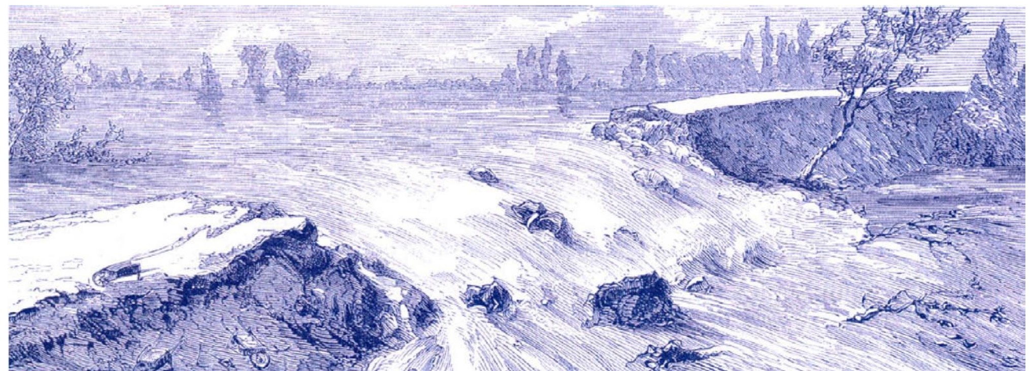
Brèche et remblai d'urgence à Cisse
